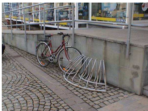
Obr. 25: Nevhodný stojan z důvodu kotvení, možného poškození stojanu a uchycení jízdního kola. Zdroj: Žáková
