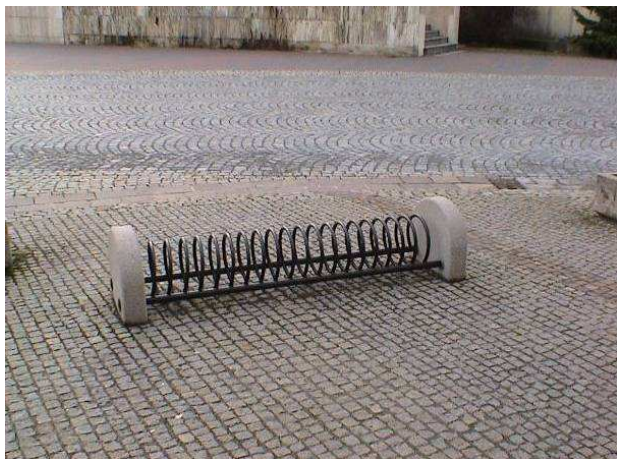
Obr. 26: Nevhodný stojan z důvodu kotvení, možného poškození stojanu a uchycení jízdního kola. Zdroj: Galatík
