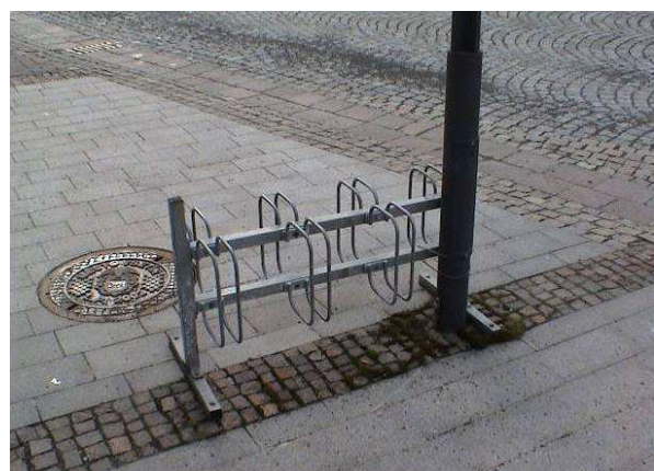
Obr. 24: Nevhodný stojan z důvodu kotvení, možného poškození stojanu a uchycení jízdního kola. Zdroj: Žáková
