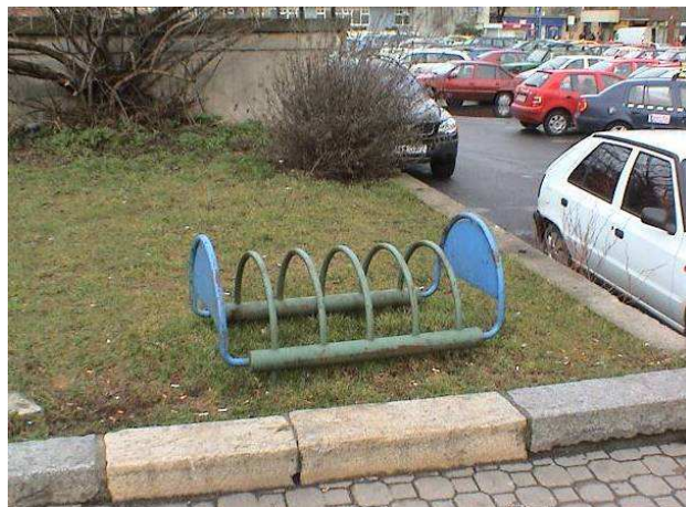
Obr. 27: Nevhodný stojan z důvodu umístění, kotvení, možného poškození stojanu a uchycení jízdního kola. Zdroj: Galatík
